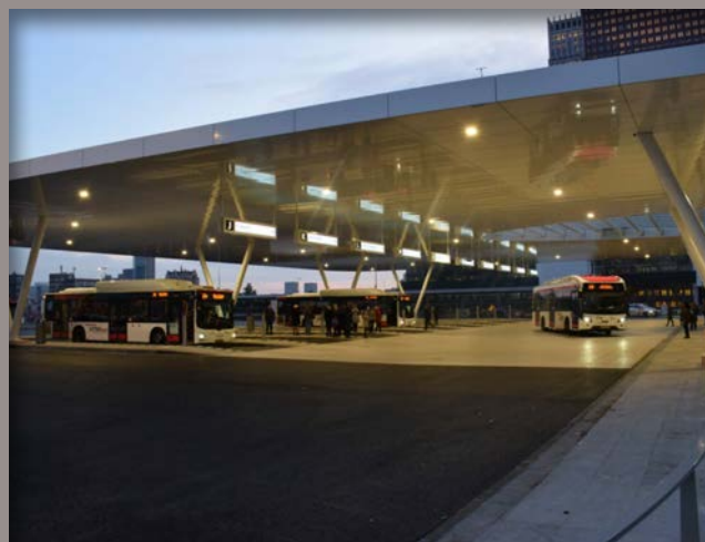
1. Opgetild busstation met overkapping
