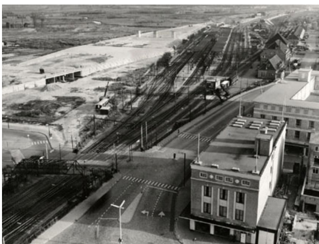
Ca. 1949, h Het spoor is nog niet verplaatst, de grond voor het nieuwe station is al bouwrijp gemaakt
